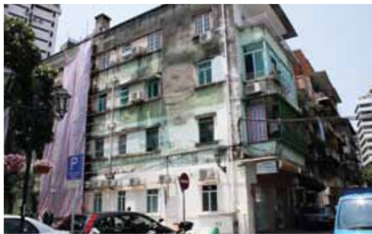
獲批「低層樓宇資助」的平安大廈進行排污渠設施維修工程
