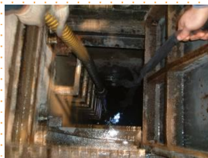
供排水泵系統
