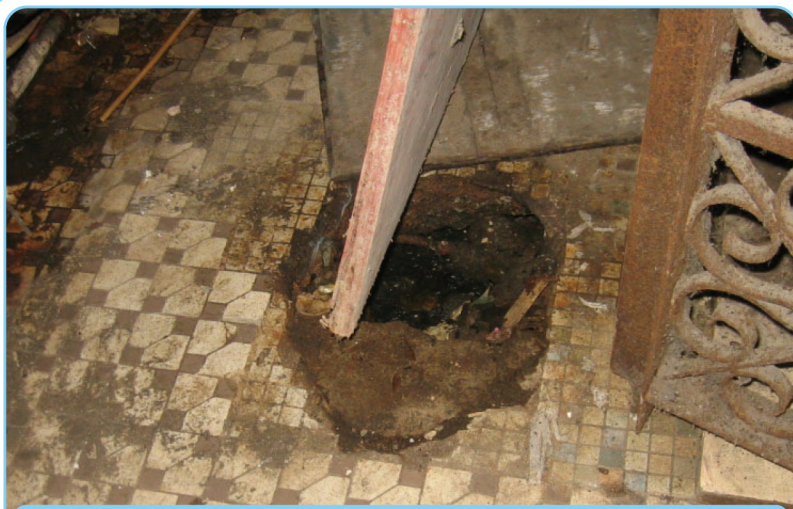
業主開鑿及疏通樓宇內出現淤塞公共渠道
