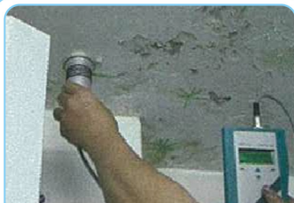
以儀器探測懷疑滲漏牆壁、天花的濕度。
