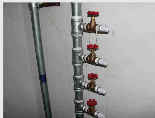
新城市花園第17座供水管系統更新
