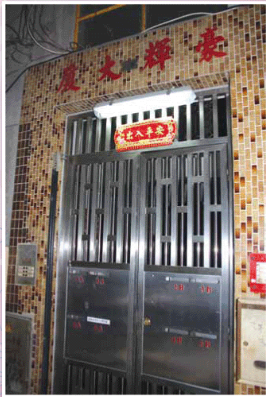
34年樓齡的豪輝大廈透過維修資助，更換大廈開門
